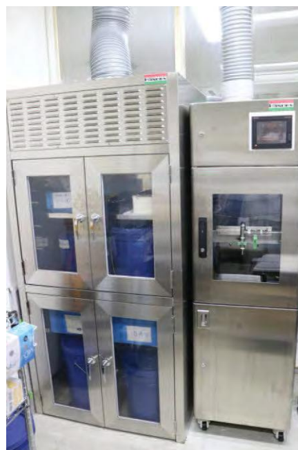
保管容器の局所排気装置付き保管庫(左) ホルマリン分注記録装置用の局所排気装置(右) (いずれも以前はなかった)
