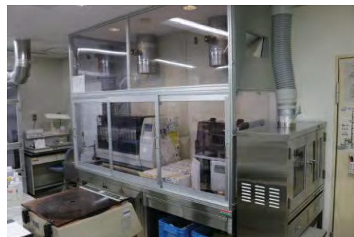
自動染色装置・自動封入装置 (囲い式局所排気装置)
