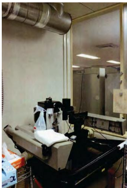
撮影装置用のプッシュプル型換気装置
